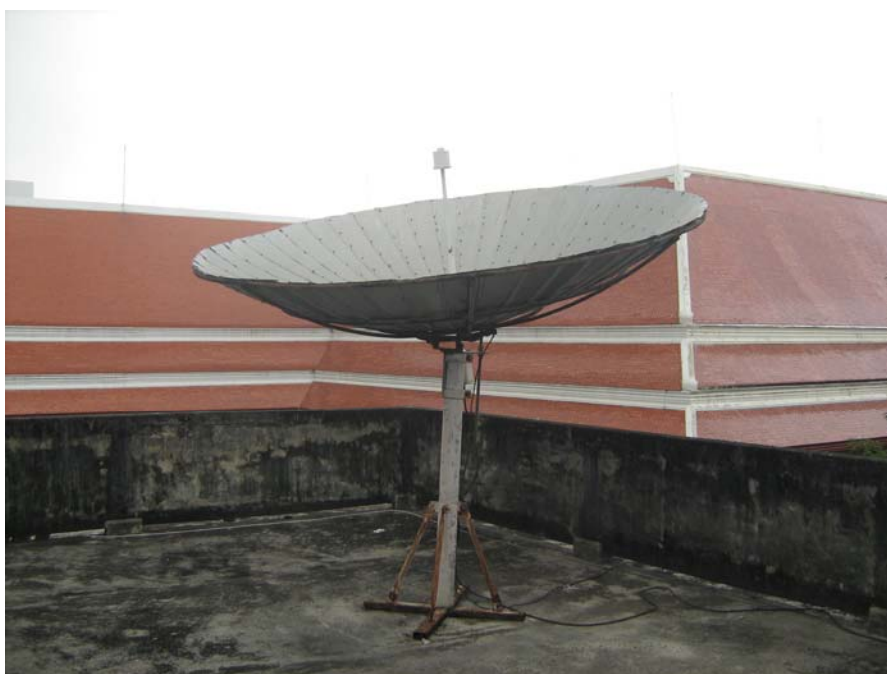
รูปที่ 4.3 สถานีรับภาพดาวเทียม FY-2D ที่จุฬาลงกรณ์มหาวิทยาลัย
