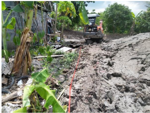
รูปที่ 13. การบดอัดคันดิน
