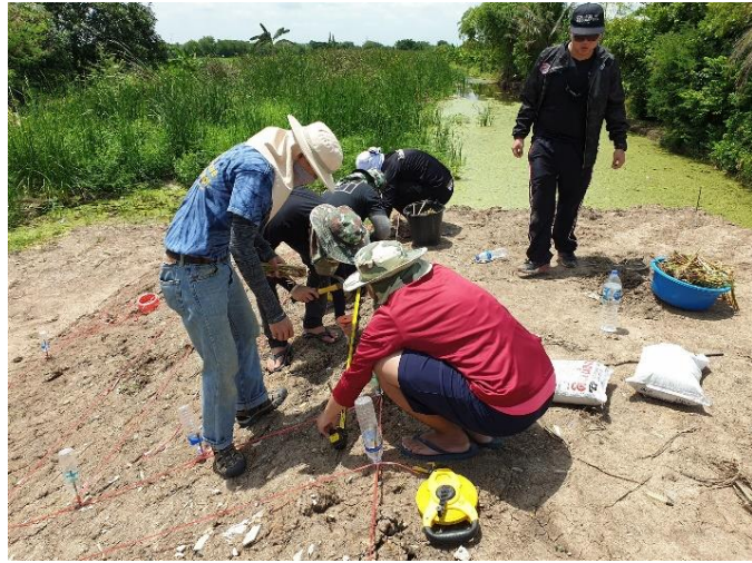
รูปที่ 17. การตีแนวการปลูกแฝกตามแนวลาดดิน
