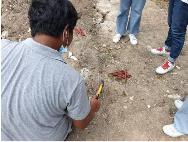
รูปที่ 25. การติดตั้งเครื่องหมายสำรวจ และการรังวัดคันดิน
