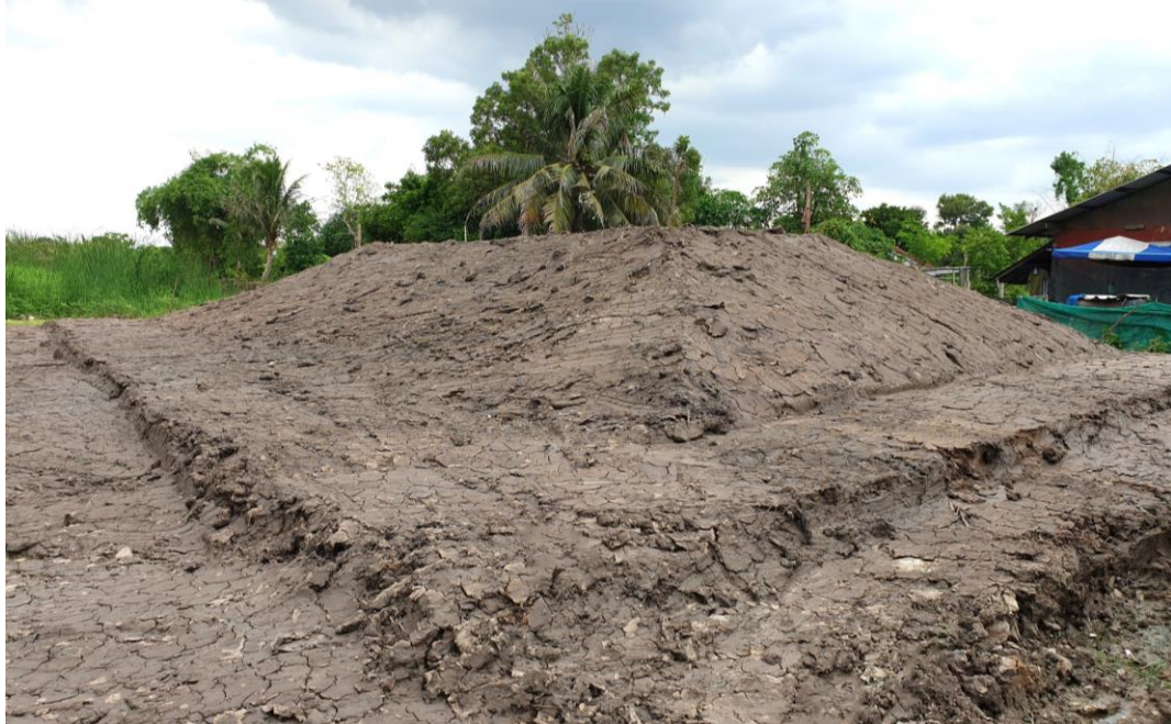
รูปที่ 14. ค้นดินหลังจากการก่อสร้างแล้วเสร็จ
